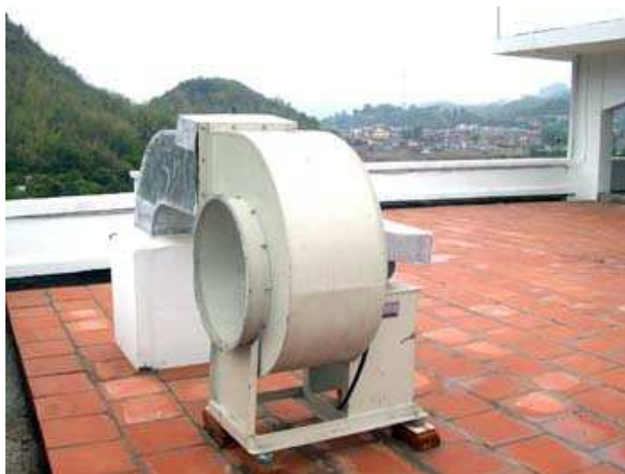
Hình 13.1. Quạt tăng áp cầu thang trên mái nhà điều hành dự án công trình thủy điện Sơn La, Tỉnh Sơn La
