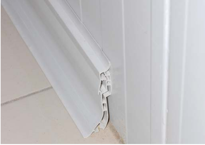
Duvar Paneli Zemin Birleşim Detayı
