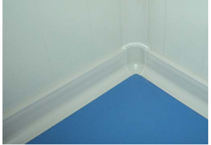
Duvar Paneli Zemin Birleşim Detayı
