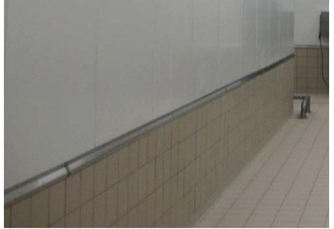
Duvar-Zemin Birleşim Detayı Wall-Floor Connection
