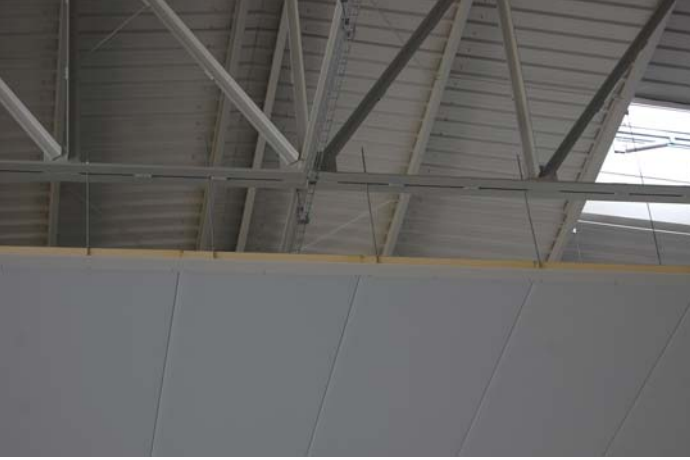
Asma Tavan Askı Detayları Suspended Ceiling Details
