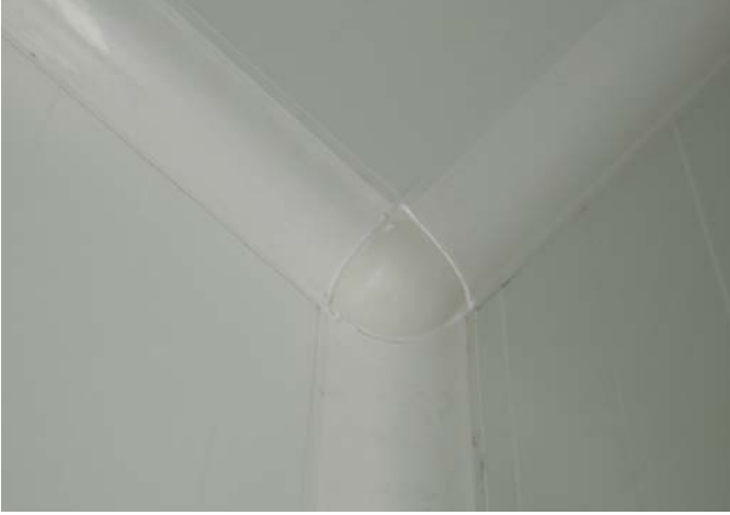
Duvar Paneli Zemin Birleşim Detayı Unification of the Floor Wall Panel Details
