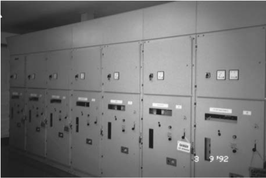
Fig. 2.1 11kV switchboard, Jersey ( Siemens plc ).
